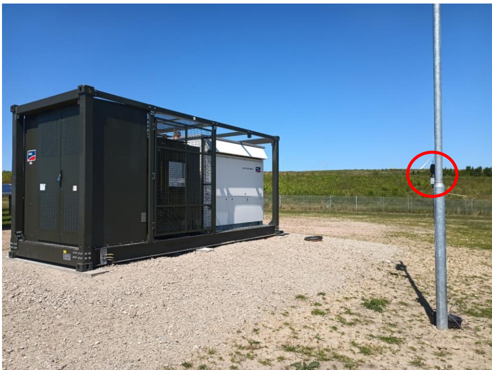
Figur 2. Placering af måleposition til måling af døgnvarians fra en samling af et kombineret inverter og transformator anlæg. Målepositionen er markeret med en rød ring.
