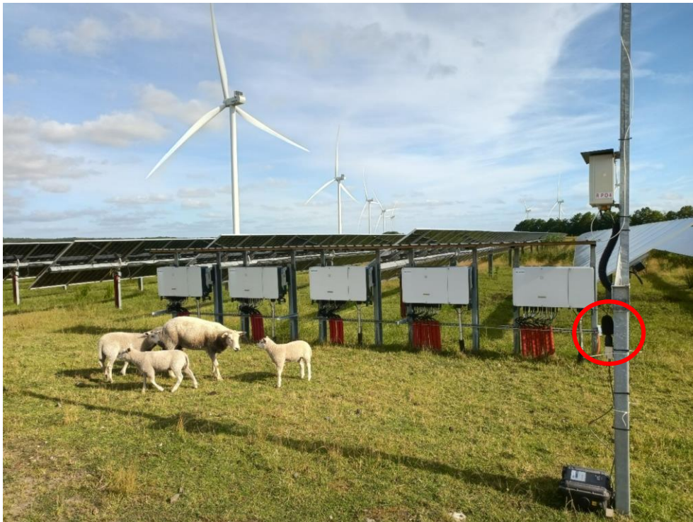
Figur 2. Placering af måleposition til måling af døgnvarians fra en samling af et kombineret inverter og transformator anlæg. Målepositionen er markeret med en rød ring.
